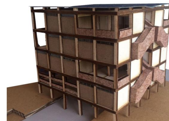
Vivienda multifamiliar modular LEGO – pórticos estructurales y paneles de cerramientos en bambú guadua laminada Multifamily modular LEGO housing – structural frames and enclosures panels in laminated bamboo guadua
