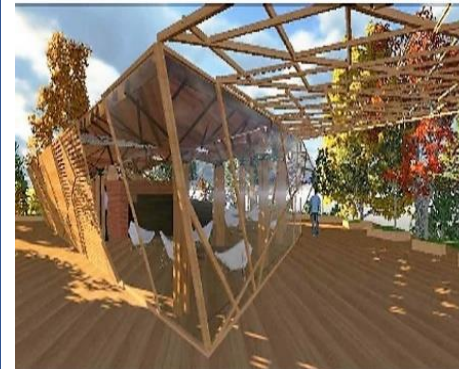
Pabellón del Café, guadua laminada y Bahareque - S.I.G. Coffee Pavilion, laminated guadua & bahareque - S.I.G. Parque Recinto del Pensamiento, Manizales
