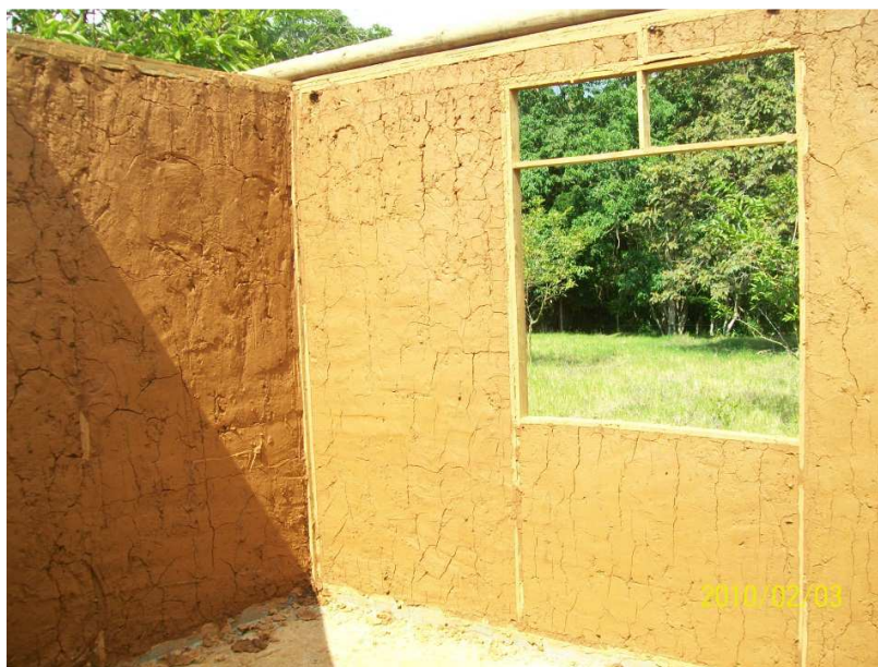
Muros en proceso de secado
