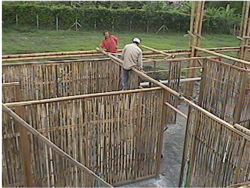
Armado de muros
