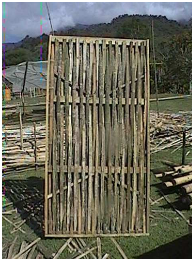
Armado de panel con latas
