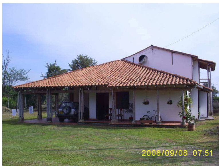
Fachada de dos pisos
