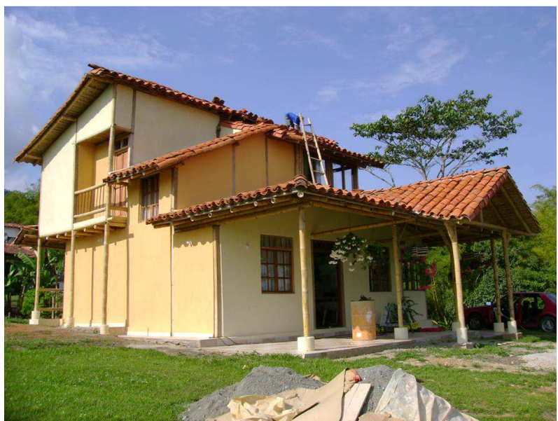
Fachada de dos pisos
