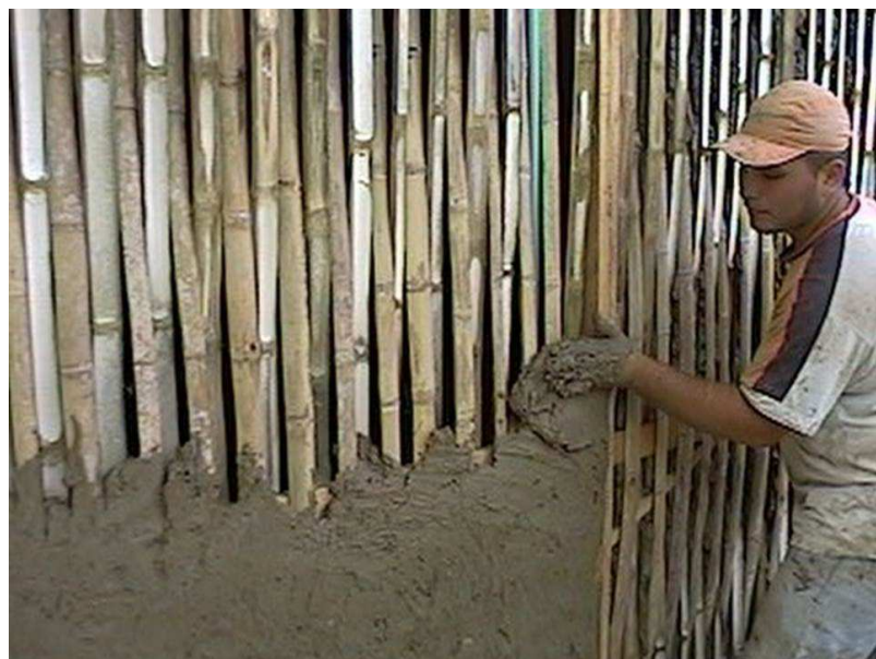
Aplicando barro al muro
