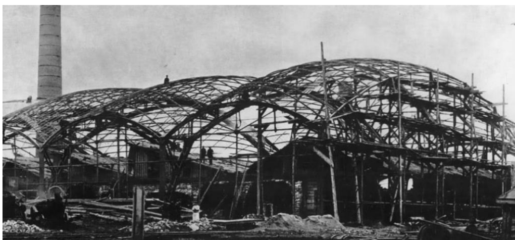
Figura 1: Durante el proceso constructivo, la primera gridshell de acero doblemente curvada del mundo (Shukhov 1897).
