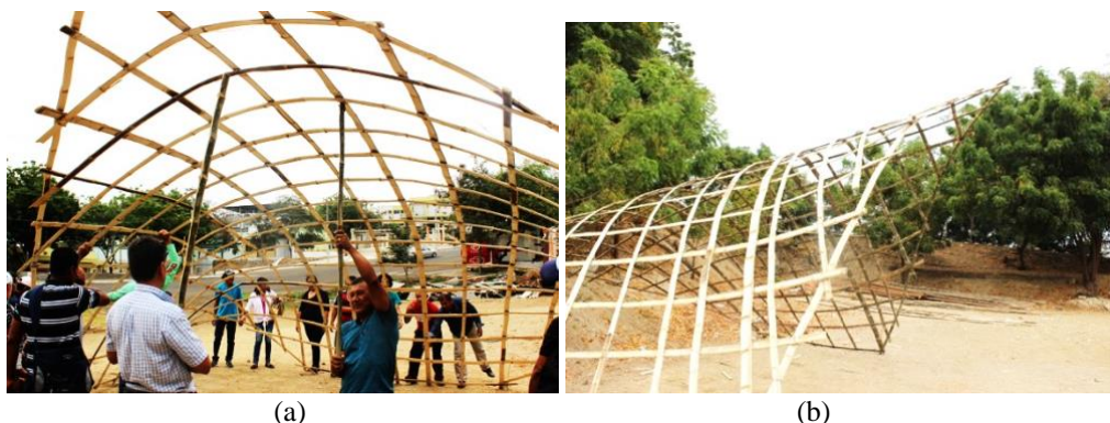
Figura 10: (a) Producción de deformaciones en las latillas, estructura inestable, (b) Estructura estabilizada al invertir la malla.
