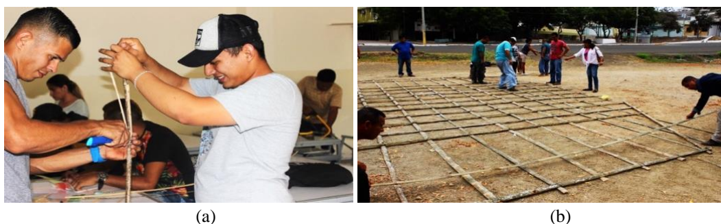
Figura 9: (a) Extracción de laminillas de guadua para la elaboración de las maquetas gridshell ; (b) Elaboración de la malla de una sola capa, utilizando el módulo de 50 cm por 50 cm.
