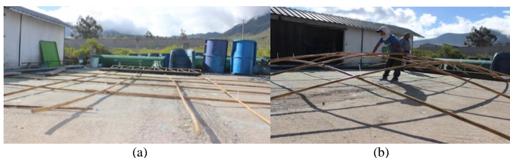
Figura 13: (a) Configuración de la malla usando culmos de Phyllostachys aurea , (b) Erección de la gridshell .
