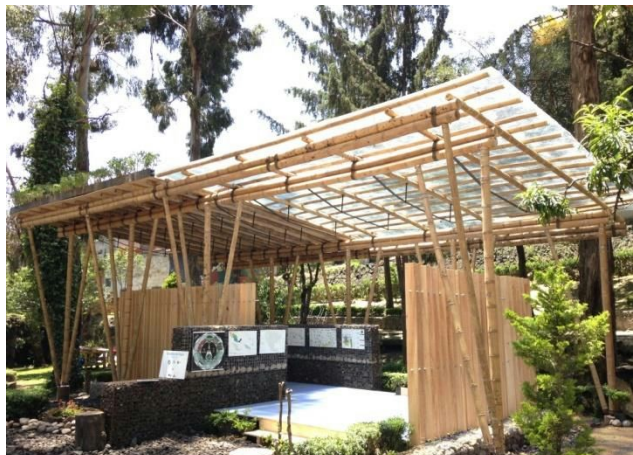
Figura 5. – Sistema Bambulosa® en el Pabellón del agua, Centro Cultural Helena Poniatovska, Del. Magdalena Contreras, Ciudad de México
