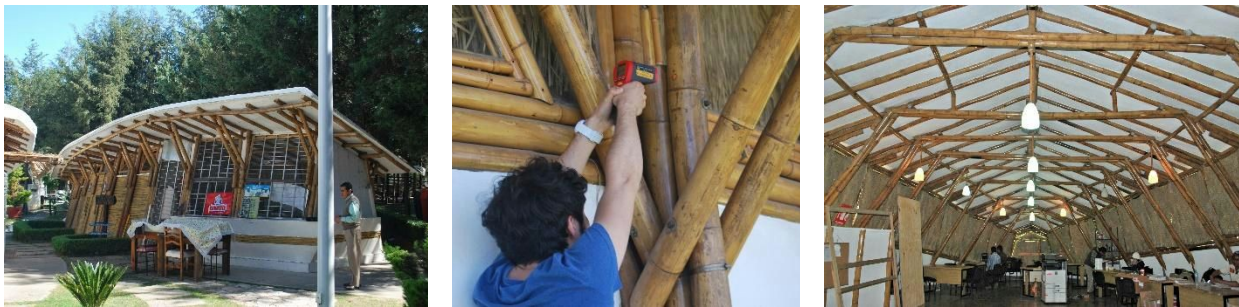
Monitoreo de construcciones existentes con estructura de bambú
