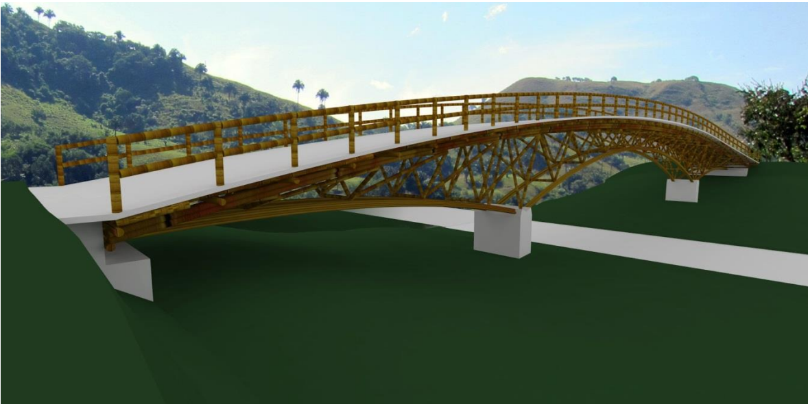
Render: Propuesta de un puente de 50 metros con estructura tetraédrica en bambú. UTP Pereira.
