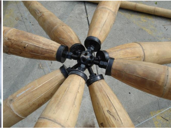
Foto: Unión con esfera "mero", estructura espacial
