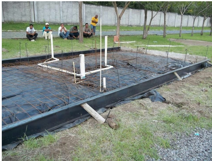
Figura 2. Preparación de plataforma e instalaciones. Elizondo (2015)
