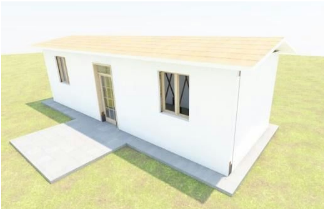
Módulo de vivienda en segunda etapa con dos recamaras, sala comedor cocina y baño, con estructura de recubrimiento en muros y techo de bahareque encementado, y teja de fibra de bambú.
