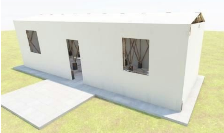
Módulo de vivienda primera etapa de 2 recamaras y espacio central de usos múltiples, con recubrimiento de lona de PVC
